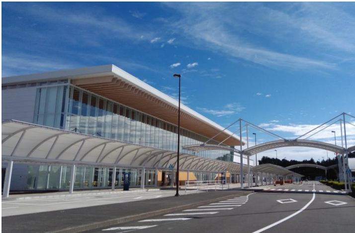
ターミナルビル外観
