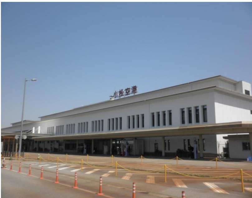
ターミナルビル外観
