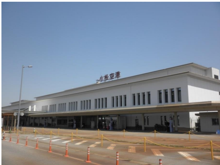
ターミナルビル外観
