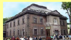
オルゴール堂本館
